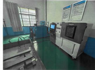
图 2：试验设备以及现场产品安装
